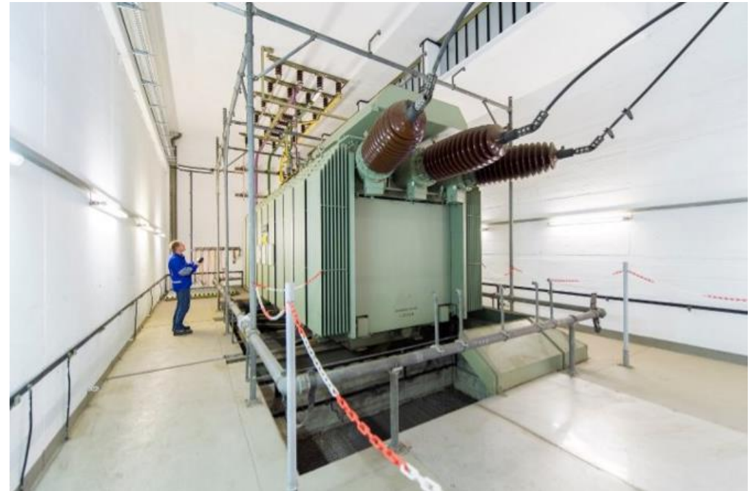
Abbildung: Innenansicht der UA Kirchhörde (Batheyweg)
